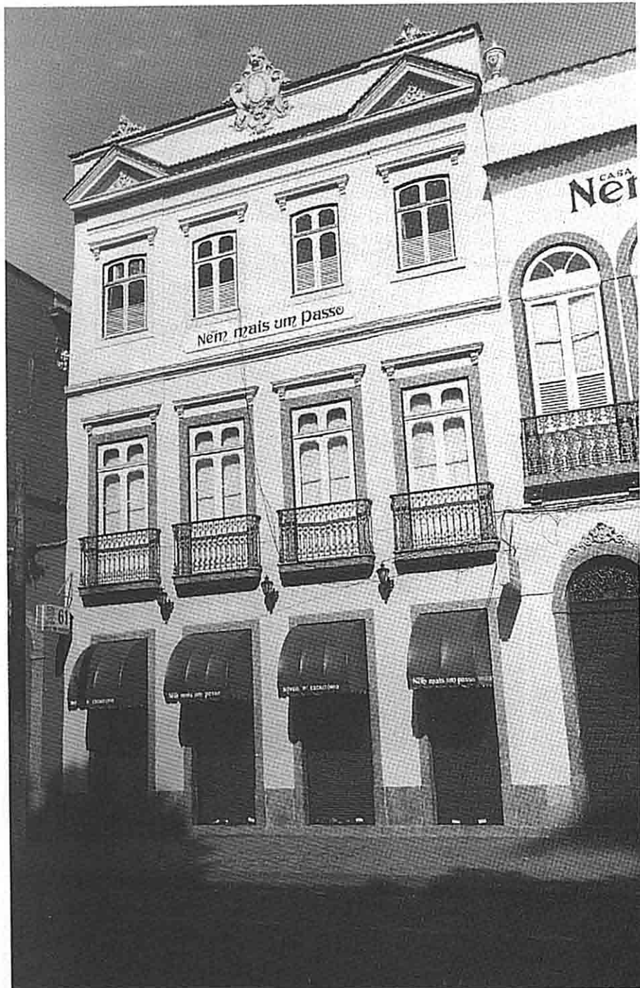
Praça da República, 61. Imóvel depois da obra de recuperação.
