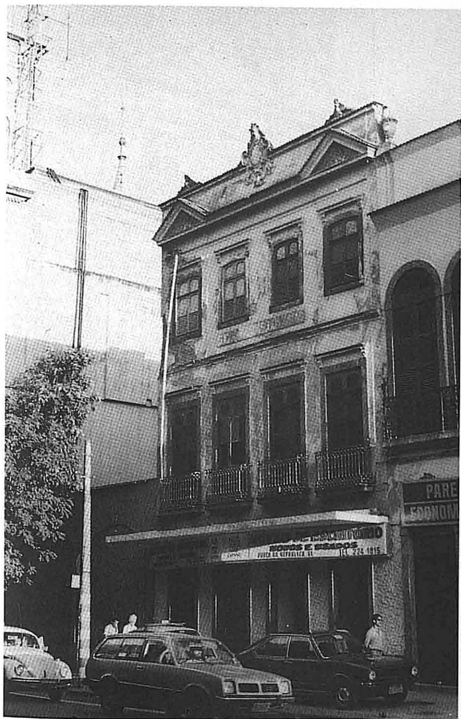
Praça da República, 61. Imóvel antes da obra de recuperação.
