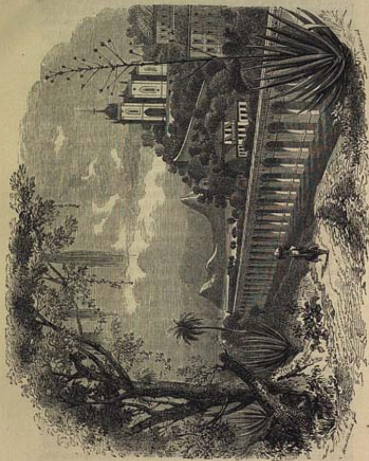
CHURCH OF NOSSA SENHOR A DA GLORIA, AND AQUEDUCT, RIO DE JANEIRO.
